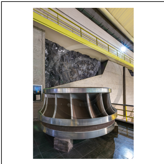
Hautes-Alpes, 05, Lac de Serre-Ponçon, Rousset, Barrage de Serre-Ponçon, usine hydroélectrique EDF, salle des machines (turbines) // Hautes-Alpes, 05, Lac de Serre-Ponçon, Rousset, Serre-Ponçon Dam, EDF hydroelectric plant, engine room (turbines)
